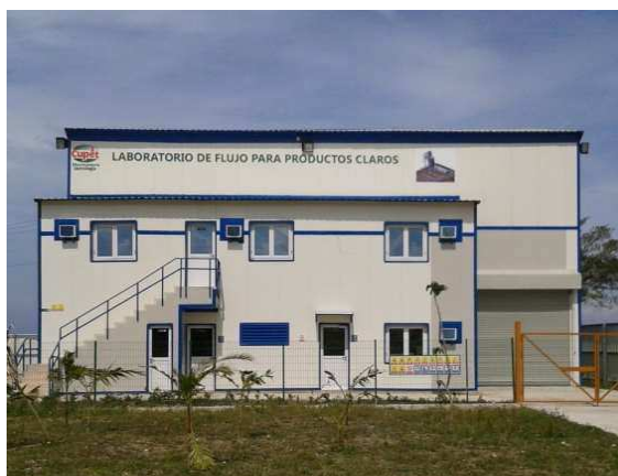
Fig. 8 Vista de la construcción del LCPC
